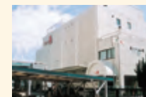
旧大森本社（現・大森工場3号館）
